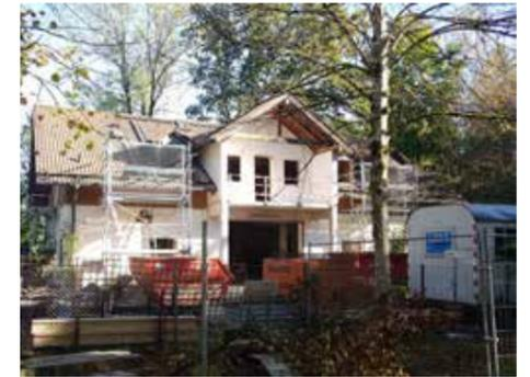
wird die Gebäudehülle energetisch saniert, eine neue große Gaube eingebaut, Fenster und Türen erneuert, Wände abgebrochen, neue aufgestellt, um eine optimale Raumaufteilung für den Kindergartenbetrieb zu erhalten. Nicht zuletzt werden die Außenanlagen kindgerecht gestaltet.
