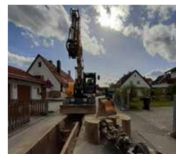
Seit Mitte September laufen die Bauarbeiten zur Erneuerung der 480 Meter langen Trinkwasserleitung in der Straße „Am Feld“. Voraussichtlich Ende November werden die Maßnahmen vorerst abgeschlossen sein. Die Kanalbau- und Straßenbauarbeiten in diesem Bereich wurden bis zur abschließenden Klärung der Finanzierung zurückgestellt.
