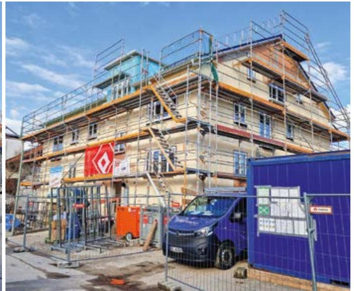
Das Wohngebäude Kranzhornstraße 12 in Grafing-Bahnhof, erbaut 1964, wird derzeit von Grund auf saniert und energetisch modernisiert. In diesem Zuge wird das bislang ungenutzte Dachgeschoss mit zwei neuen Wohnungen ausgebaut, so dass nach Abschluss der Maßnahme insgesamt 8 Wohnungen mit einer Gesamtfläche von 524 m<sup>2</sup> zur Verfügung stehen.
