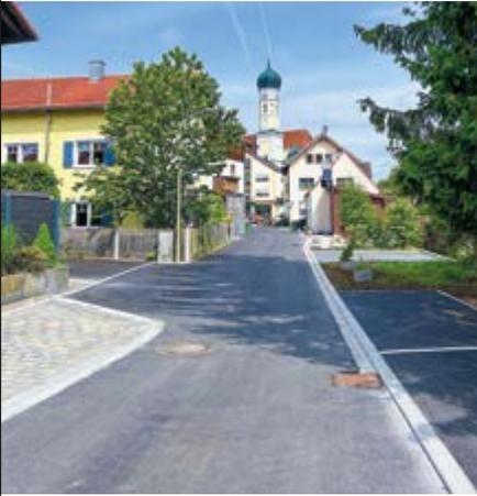
Im Zeitraum vom 17.03. bis 20.05.2025 wurden in der Mühlenstraße die Gasleitung, die Straßenentwässerung, Vorbereitungen für die Breitbandversorgung getroffen, sowie die Fahrbahnoberfläche erneuert.
