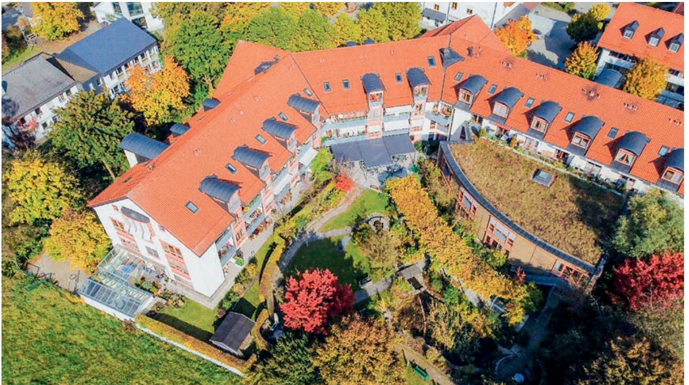
Blick in den Innenhof mit der herrlichen Gartenanlage
