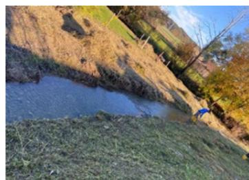
entlandet, die Bachböschungen und Ufervorländer wurden gemäht, Gehölze im Abflussquerschnitt zurückgeschnitten, lokale Treibholzanlandungen entnommen sowie das Ufer in gewissen Böschungsbereichen gesichert.
