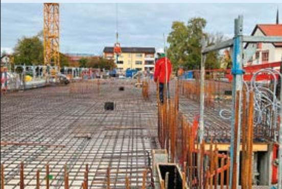
Vorbereitung Betonage Decke über EG im Westflügel
